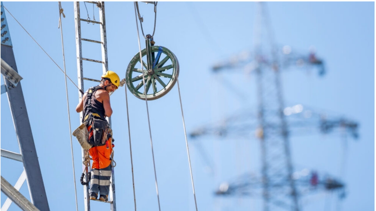
Arbeiten an einer Hochspannungsleitung in Sitten. (Bild: Keystone)
